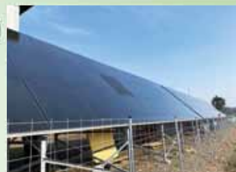
一不具合パネル特定交換工事
